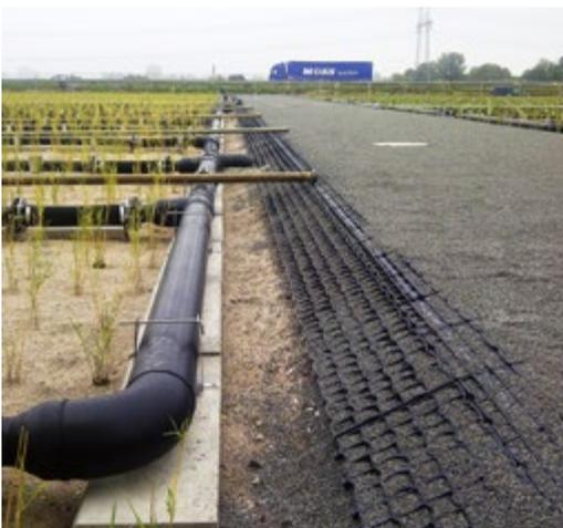
*„Das ECORASTER® - System zur befahrbaren Befestigung des Mitteldammes zwischen den einzelnen Pflanzenbeeten und bei dem umlaufenden Damm erweist sich für den vorliegenden Anwendungsfall als die beste mögliche Anwendungsvariante: einfache und schnelle Verlegung durch eigenes Personal, problemlose Anpassung an die vorgegebenen Geländeverhältnisse, Befahrbarkeit durch schwere landwirtschaftliche Fahrzeuge und kostengünstige Alternative.“*
